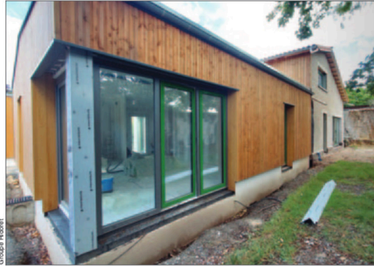
Angle vitré du salon à plusieurs vantaux, avec menuiseries classiques et menuiseries EnR chauffantes.
