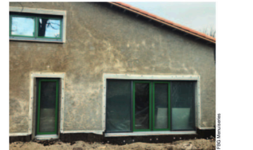
Les menuiseries EnR pariéto-dynamiques sont à ouvrants alu de teinte verte et les classiques sont en PVC plaxé alu gris
